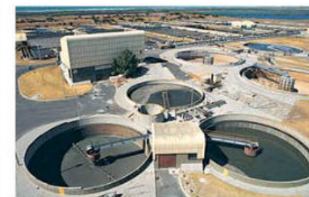
Figura 1.26 Piscina de decantación. Los residuos más livianos flotan y los más densos sedimentan.
