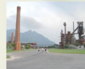
Figura 4.32 En el Parque Fundidora de Monterrey podemos apreciar el proceso de la corrosión.
